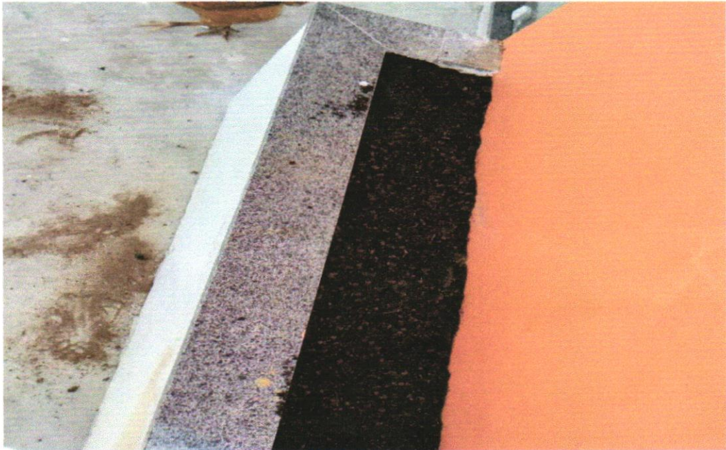
Foto 07- SOLEIRA EM MÁRMORE, LARGURA 15 CM, ESPESSURA 2,0 CM. AF_09/2020
