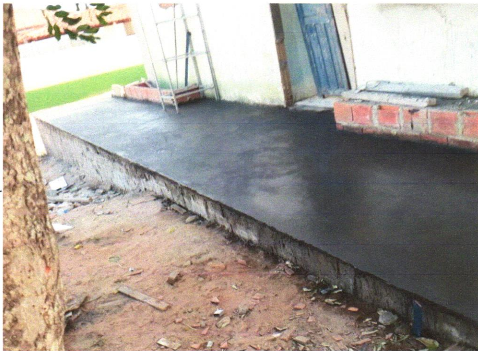
Foto 21 – EXECUÇÃO DE PASSEIO (CALÇADA) OU PISO DE CONCRETO COM CONCRETO MOLDADO IN LOCO, FEITO EM OBRA, ACABAMENTO CONVENCIONAL, ESPESSURA 8 CM, ARMADO. AF_07/2016
