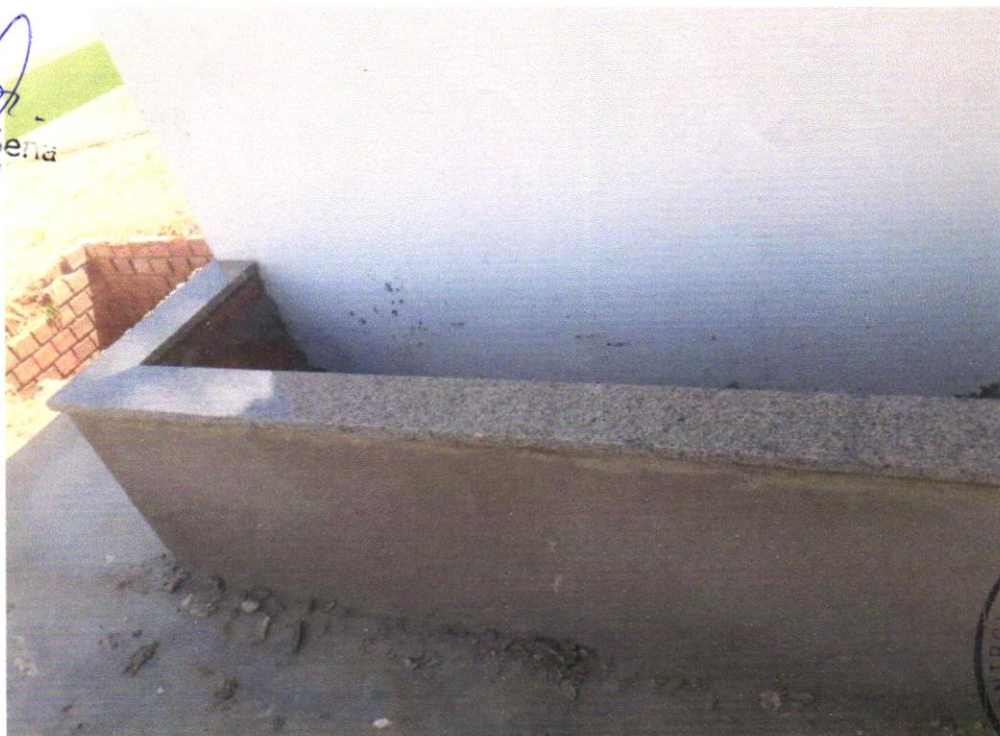
Foto 08- SOLEIRA EM MÁRMORE, LARGURA 15 CM, ESPESSURA 2,0 CM. AF_09/2020
