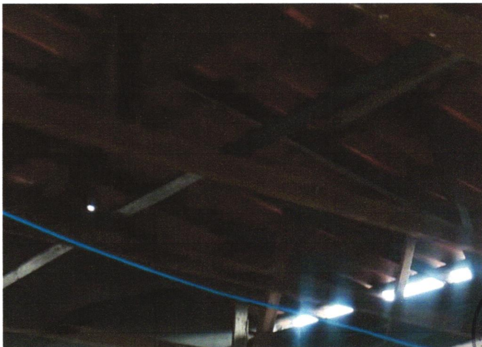
Foto 10 - CABO DE COBRE FLEXÍVEL ISOLADO, 4 MM 2 , ANTI-CHAMA 0,6/1,0 KV, PARA CIRCUITOS TERMINAIS - FORNECIMENTO E INSTALAÇÃO. AF_12/2015
