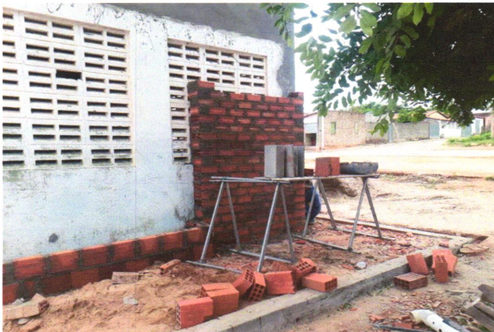
Foto 19 – ALVENARIA DE VEDAÇÃO DE BLOCOS CERÂMICOS FURADOS NA HORIZONTAL DE 9X19X29 CM (ESPESSURA 9 CM) E ARGAMASSA DE ASSENTAMENTO COM PREPARO EM BETONEIRA. AF_12/2021
