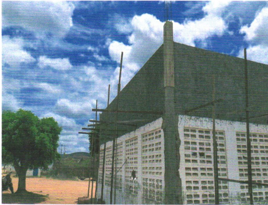
Foto 31- (COMPOSIÇÃO REPRESENTATIVA) EXECUÇÃO DE ESTRUTURAS DE CONCRETO ARMADO, PARA EDIFICAÇÃO HABITACIONAL UNIFAMILIAR TÉRREA (CASA EM EMPREENDIMENTOS), FCK = 25 MPA. AF_01/2017
