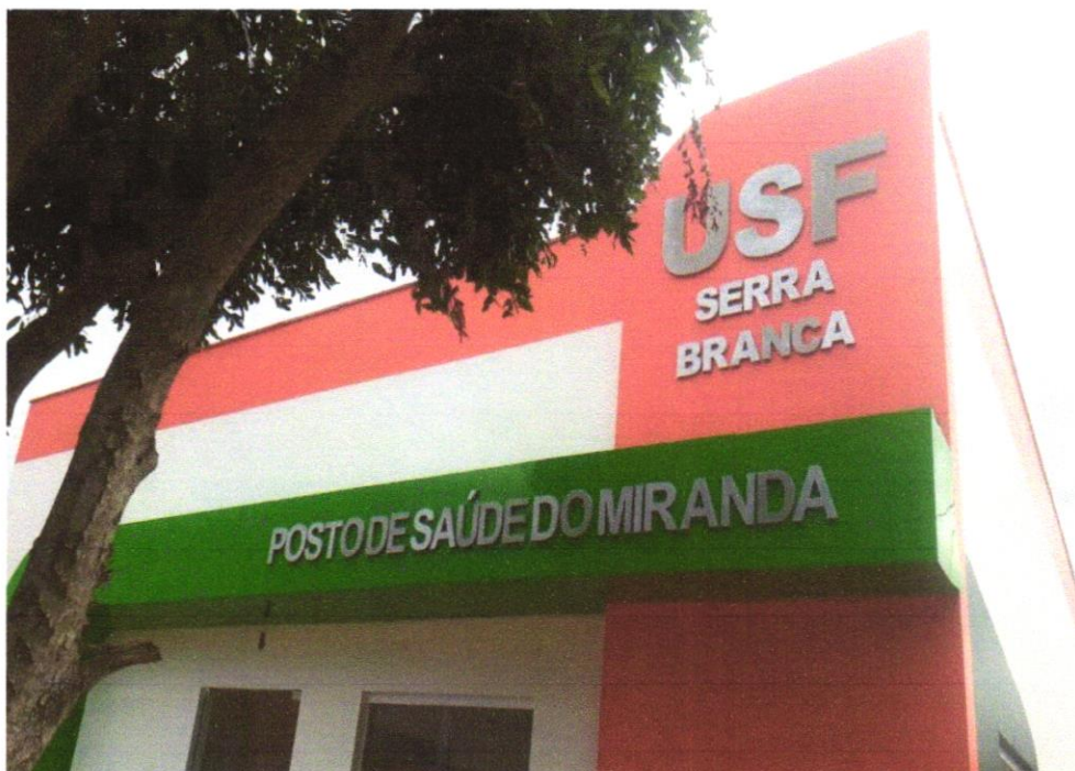
Foto 11- Letra em alumínio 15 x 15cm – instalado
