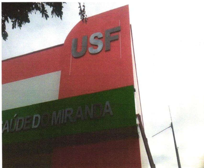
FOTO03-Letra em alumínio 45 x 45cm – instalado
