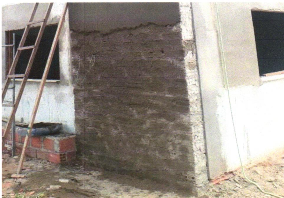
Foto20 – CHAPISCO APLICADO EM ALVENARIA (COM PRESENÇA DE VÃOS) E ESTRUTURAS DE CONCRETO DE FACHADA, COM EQUIPAMENTO DE PROJEÇÃO. ARGAMASSA TRAÇO 1:3 COM PREPARO EM BETONEIRA 400 L. AF_06/2014
