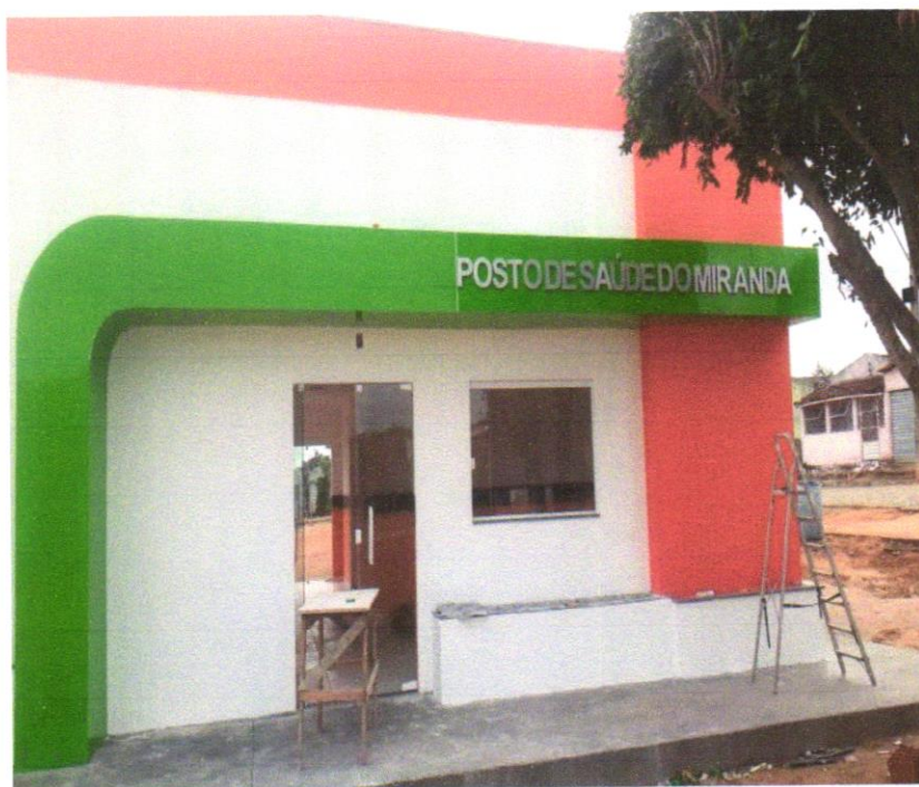
FOTO 04-APLICAÇÃO MANUAL DE PINTURA COM TINTA LÁTEX ACRÍLICA EM PAREDES, DUAS DEMÃOS. AF_06/2014
