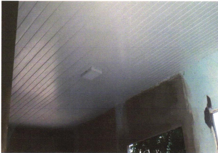
Foto 25 – Luminária sobrepor quadrada Led 24W*, 6500K G- Light ou similar
