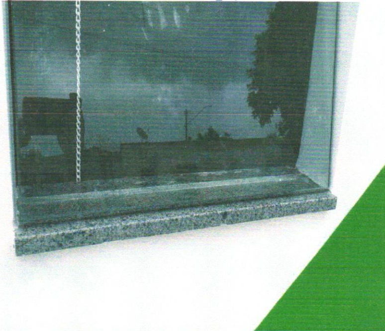
Foto 32 - PEITORIL LINEAR EM GRANITO OU MÁRMORE, L = 15CM, COMPRIMENTO DE ATÉ 2M, ASSENTADO COM ARGAMASSA 1:6 COM ADITIVO. AF_11/202
